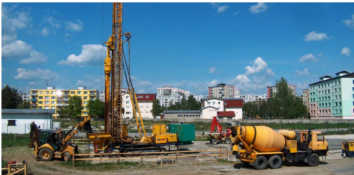
▲ Zhotovovanie betónových vibrostĺpov – pracovná zostava
