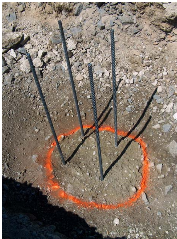
▲ Odkopaný betónový vibrostĺp
