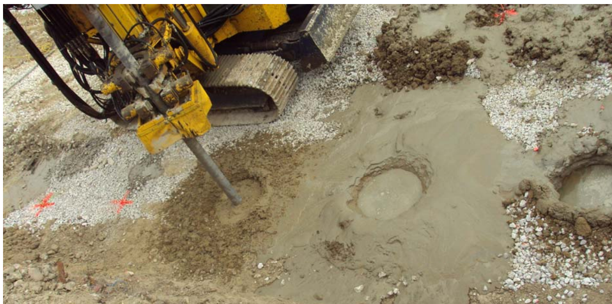
◀ Odkopaný a začistený stĺp DSM
