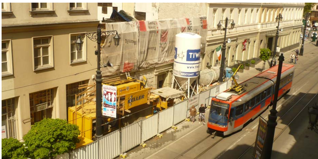
▲ Zariadenie staveniska v centre Bratislavy, v susedstve hotela Carlton.
