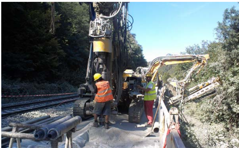
▲ Zhotovovanie mikropilót a kotiev
