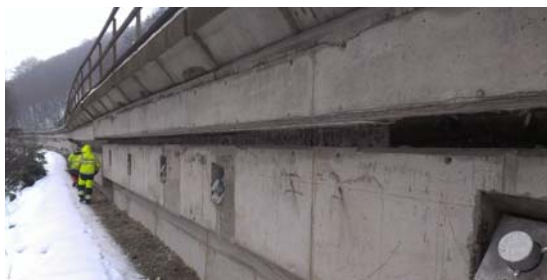
▼ Predsadená železobetónová stena s kotevnými hlavami
