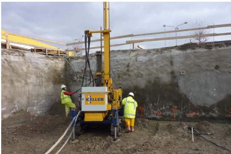
▲ Súprava Soilcrete®, pažiacia stena
