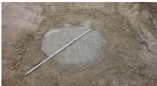
▲ Odkopaná a začistený stĺp tryskovej injektáže
