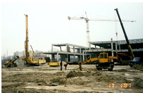
Zhotovovanie injektovaných štrkových vibrostĺpov pod parkovací dom
