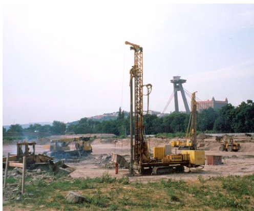
Zhotovovanie hĺbkového vibračného zhutnenia pre časť obchodné centrum
