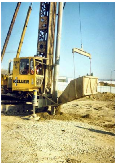
▲ Súprava hĺbkového vibračného zhutňovania pri práci
