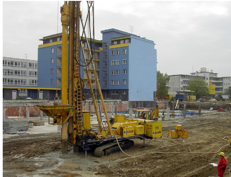
Zhotovovanie injektovaných štrkových vibrostĺpov
