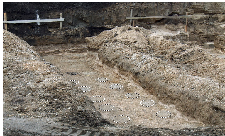
Výkop základového pásu s injektovanými štrkovými vibrostĺpmi
