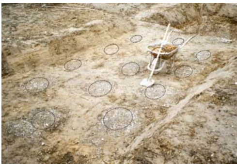
▲ Odkopané štrkové vibrostĺpy
