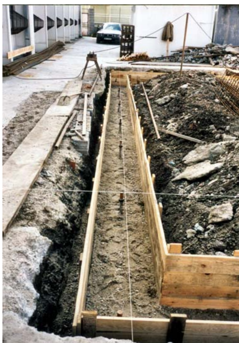
▲ Koreňové pilóty v základovom páse
