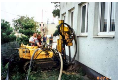
▲ Vrtná súprava pri práci
