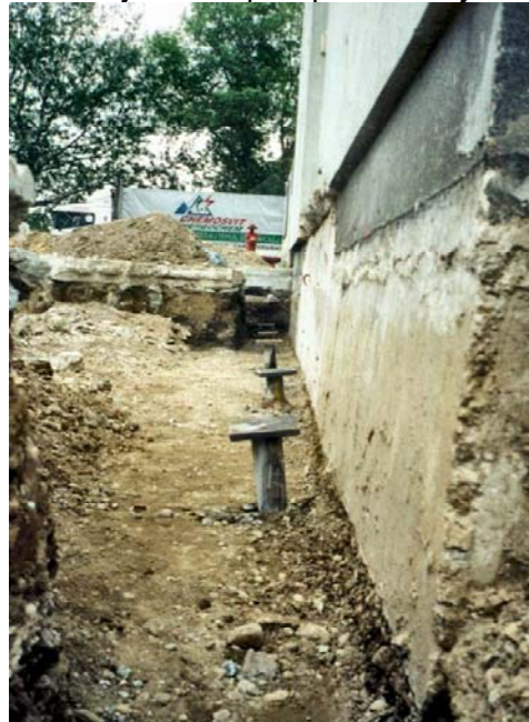
▲ Pohľad na koreňové pilóty
