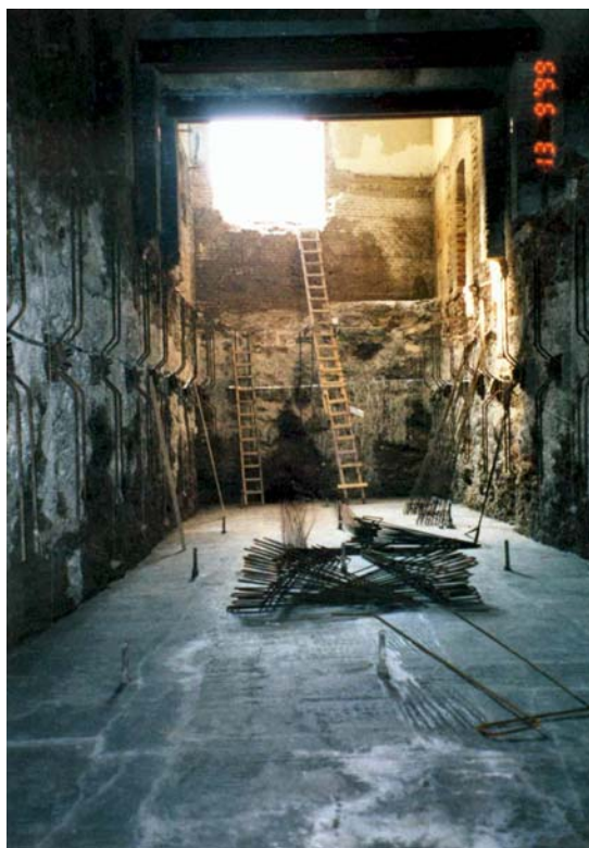
▲Prehĺbený suterén budovy o 5,0 m
