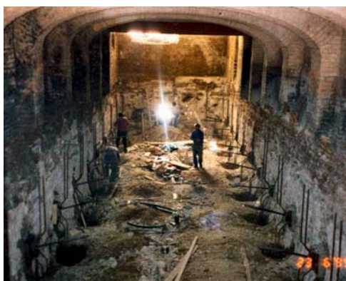
▲Kotvenie stĺpov Soilcretu
