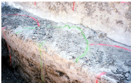
Zhotovené polstĺpy SOILCRETE pod nábrežným múrom v Záhorskej Vsi
