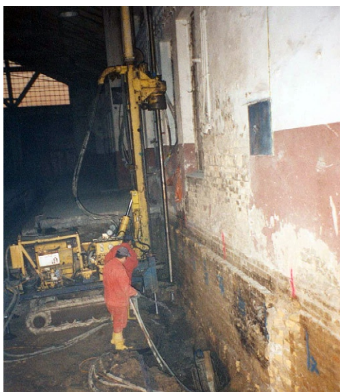
Podchytávanie stien haly soilcretom
