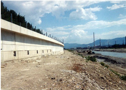
Pohľad na opornú konštrukciu
